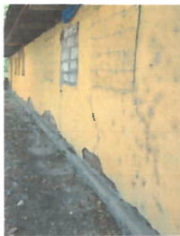
Foto 3: REPARACIÓN DE REPELLO Y CERNIDO DE PAREDES
